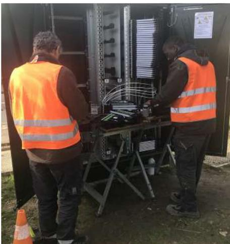
Une majeure partie de l'installation à Pontcarré se fait en utilisant les fourreaux souterrains existants, comme vous avez pu le voir par exemple dans les rues de La Ferrandière. Les câbles de la fibre sont installés et tirés d'une trappe à l'autre, le long des rues. Ces câbles sont ensuite branchés sur les PBO. Tout n'est pas terminé à ce jour.
